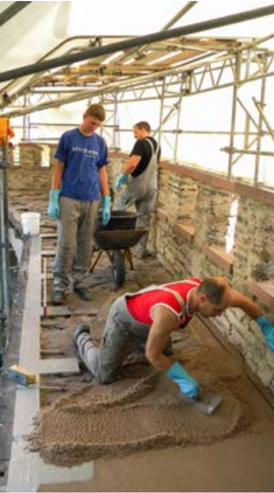
Schloss Stolzenfels – Sanierung eines historischen Wehrganges
