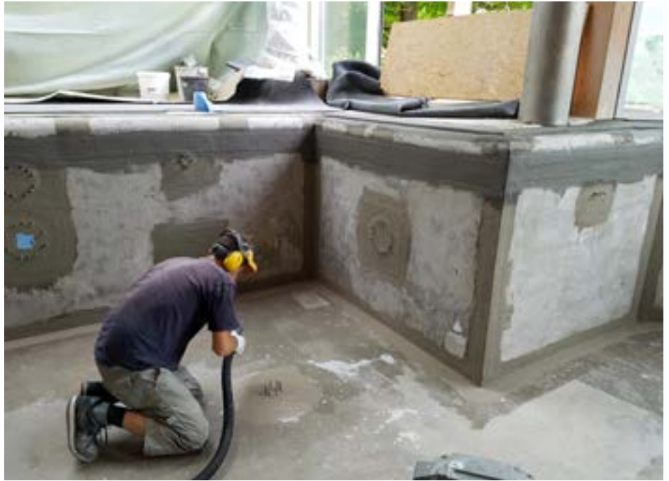
Sanierung eines undichten Schwimmbekens bestehend aus Fertigbeton-Teilen
