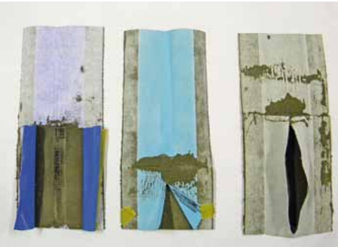
Begrenzte Adhäsionshaftung in der Überlappungszone der Abdichtbänder.
