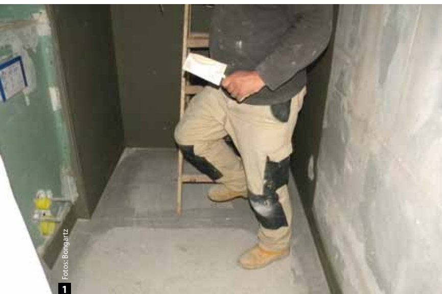
1 Nachfolgende Gewerke beschädigen die AIV in einer Dusche.
