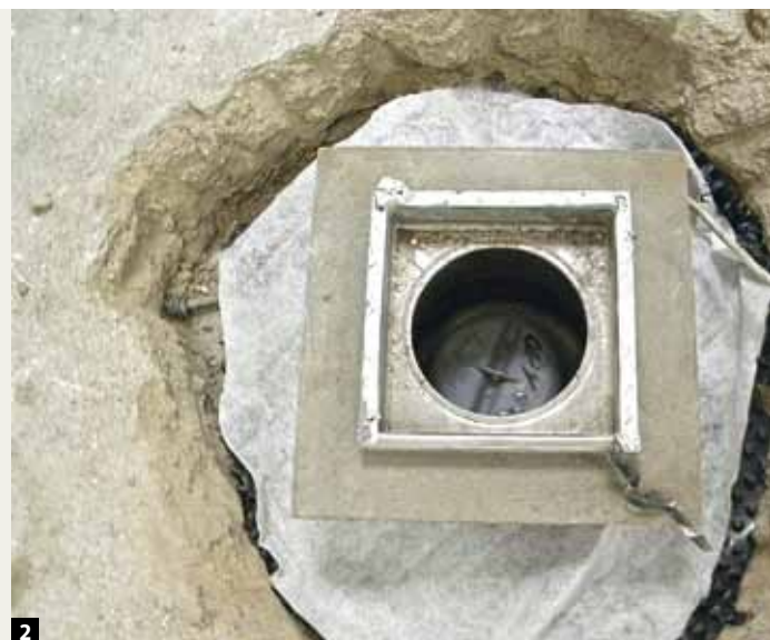
2 Von der Planung vergessen: Einbauteile, wie zum Beispiel Bodenabläufe
